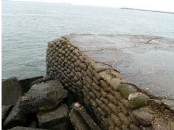
De noordpier IJmuiden gebouwd met cementzakken
