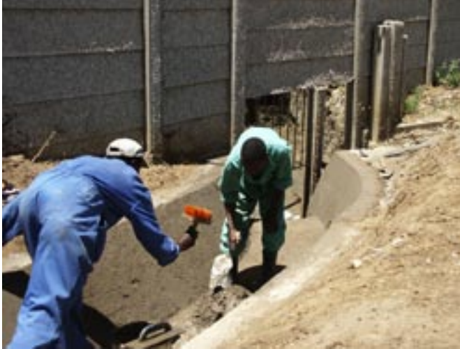
Chikanga Sportcomplex, drainagewerk
